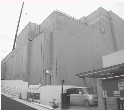
北区に建設中の特養「駒どりの郷」
